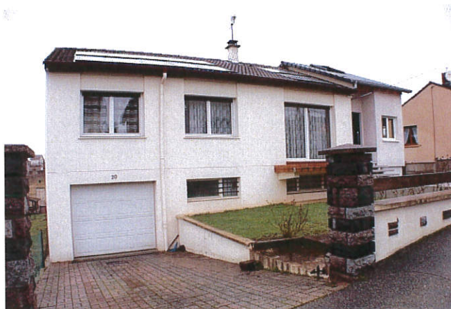
Figure 4.8.1 : Maison individuelle récente sur deux niveaux
