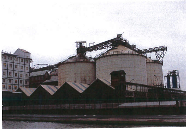
Figure 4.2.3 : Constructions industrielles de forme complexe
