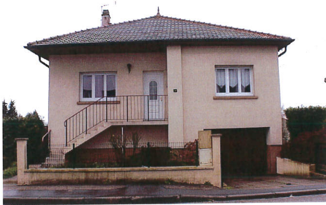
Figure 4.7.7 : Maison individuelle récente sur deux niveaux
