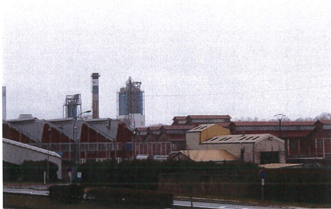
Figure 4.2.2 : Constructions industrielles de forme complexe
