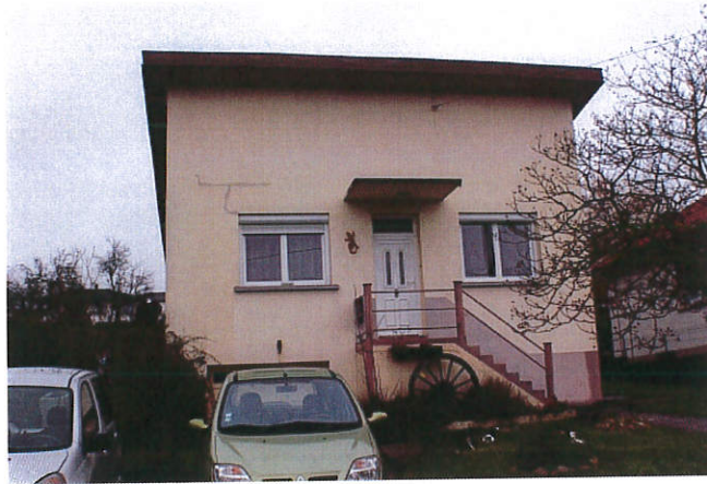
Figure 4.3.2 : Maison individuelle relativement récente avec sous-sol partiel
