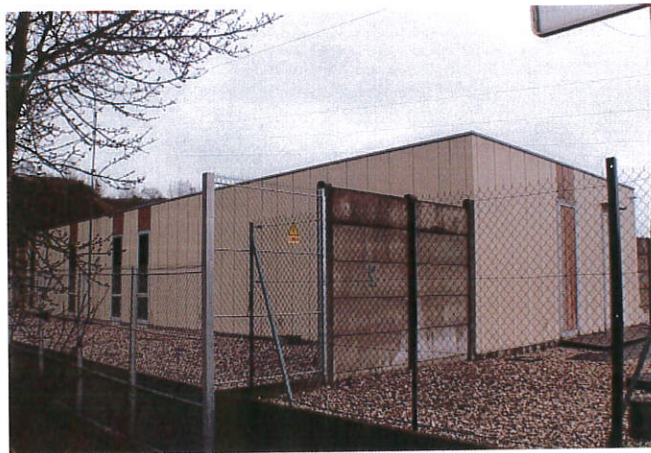
Figure 4.1.2 : Bâtiment d'activité de grand volume
