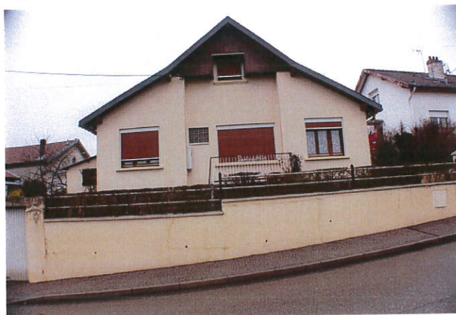
Figure 4.8.4 : Maison individuelle récente sur un terrain de pente importante
