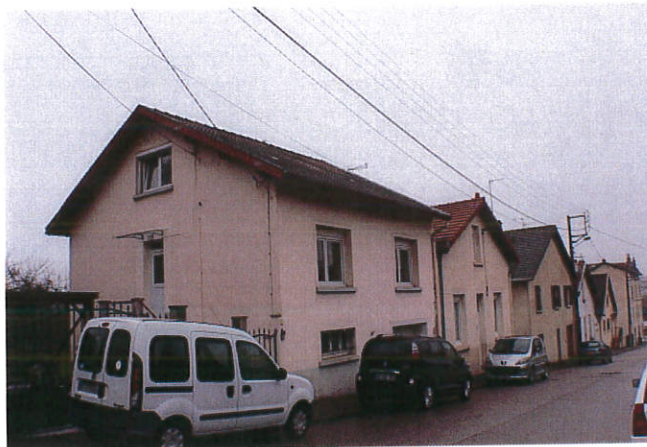
Figure 4.6.8 : Maisons individuelles sur terrain de pente importante
