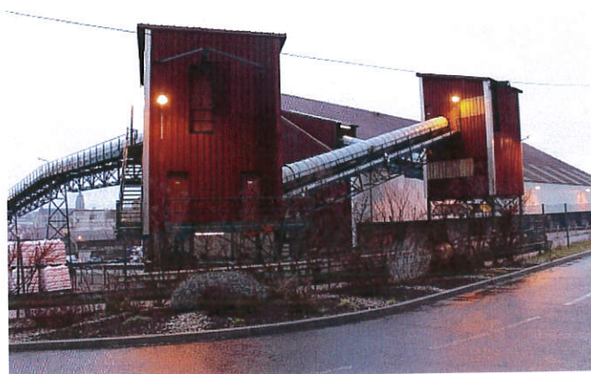
Figure 4.5.8 : Constructions industrielles à ossature métallique
