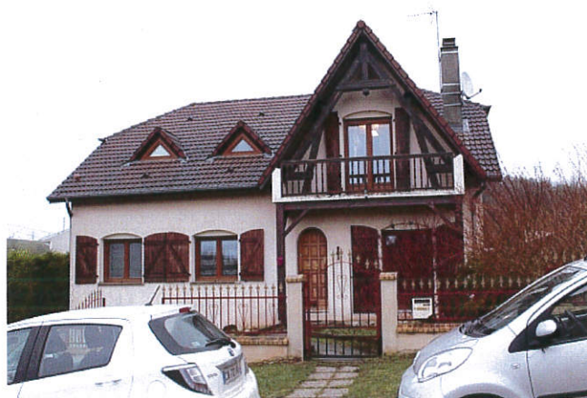
Figure 4.9.2 : Maison individuelle récente sur deux niveaux sans sous-sol avec une toiture complexe
