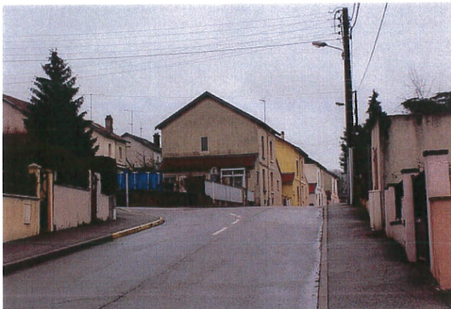
Figure 4.8.5 : Maisons sur un terrain de pente importante
