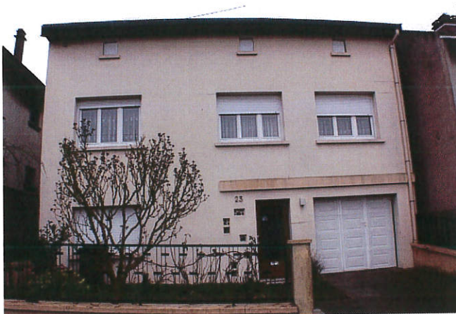
Figure 4.8.2 : Maison individuelle récente sur deux niveaux
