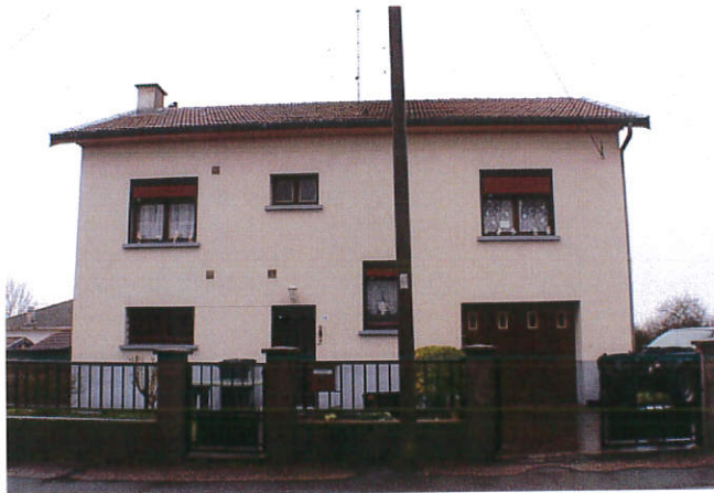
Figure 4.7.8 : Maison individuelle récente sur deux niveaux
