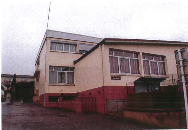
Figure 4.6.10 : Bâtiment recevant du public
